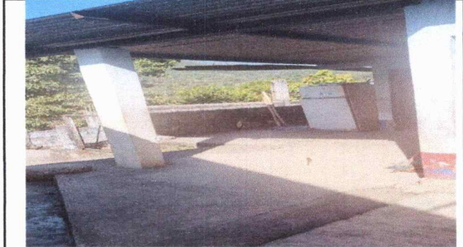
Foto 4: Construir una pared para ampliación de la cocina.
