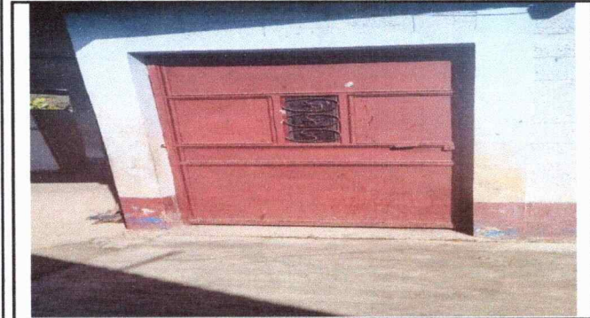
Foto1: Cambio de chapa y pintura de puerta.
